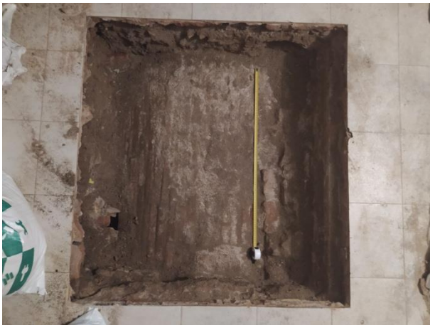
3. Volta UE 03 de la fossa sèptica.
