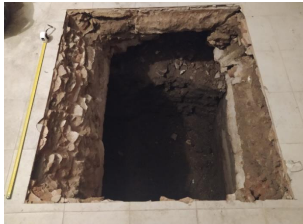
6. Fossat un cop finalitzada l'excavació
