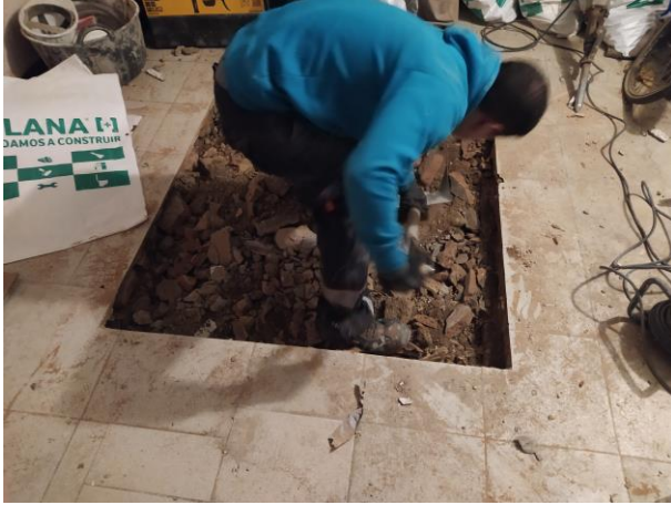
1. Treballs de retirada del paviment UE 01
